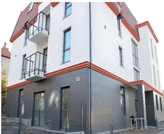
Kamienica w Gdyni
